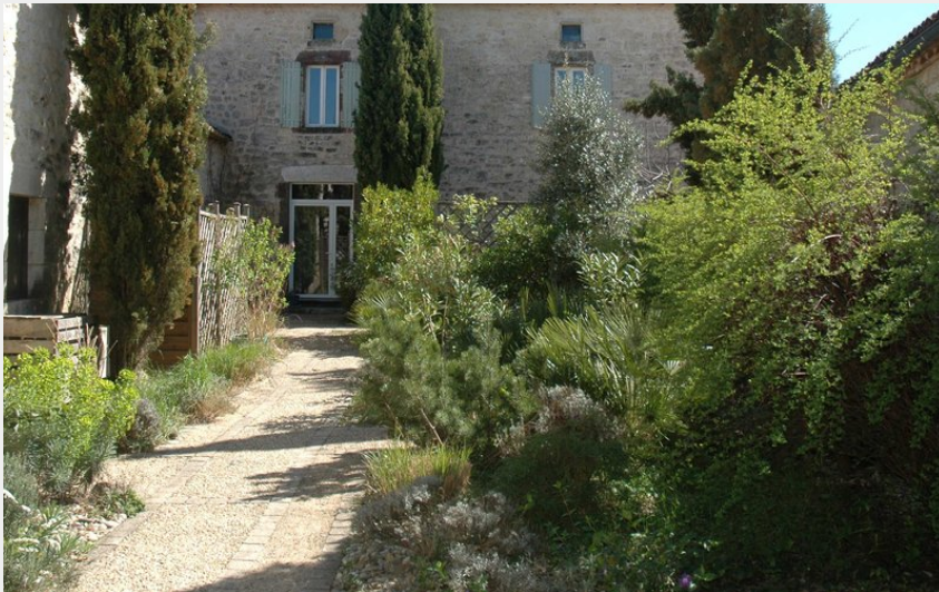
Crédit : façade cour intérieure (Didier Perthuison)
