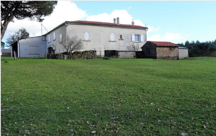
Crédit : façade Ouest (Gîtes de France)
